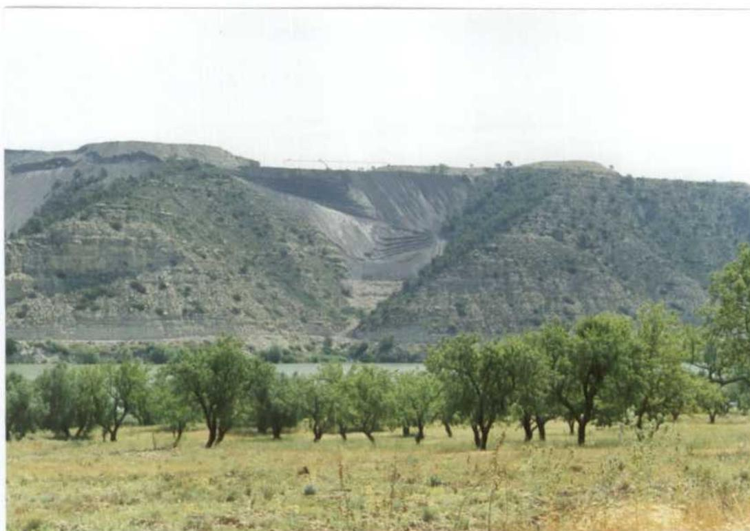
FOTO N° 11: Inestabilidad (y pequeñas bermas para reducirlas) en escombrera de lignito en Mequinenza.
