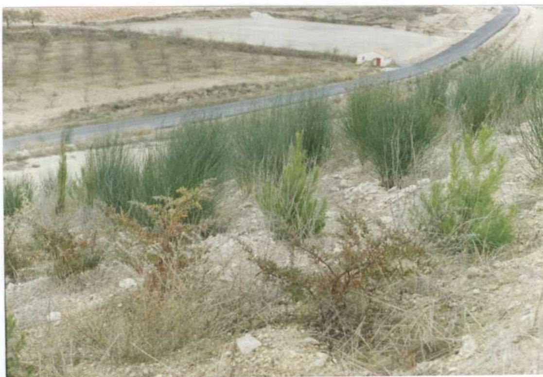
FOTO N<sup>o</sup> 4: Detalle de vegetación cultivada en talud de escombrera de la mina de Sepiolita.
